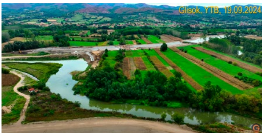
Radovi na proseku meandra Zapadne Morave
